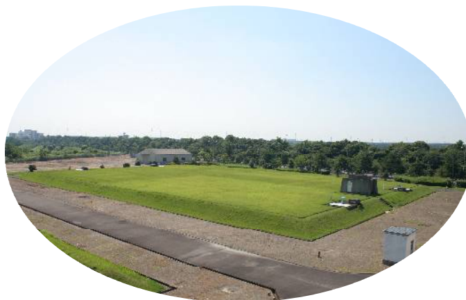
◆ 弥富配水場配水池 ◆
