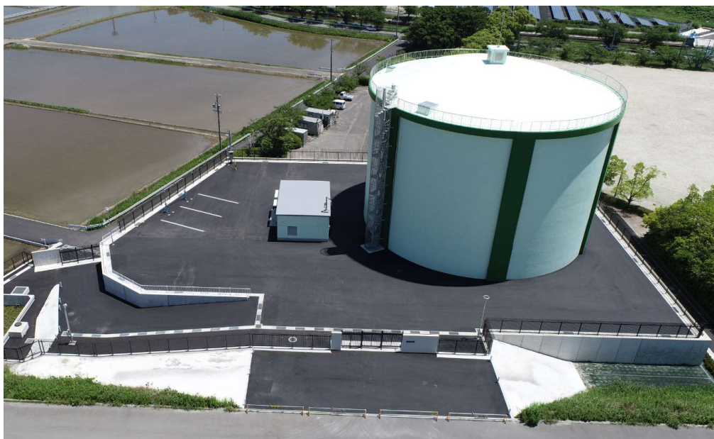
愛知県海部広域調整池
